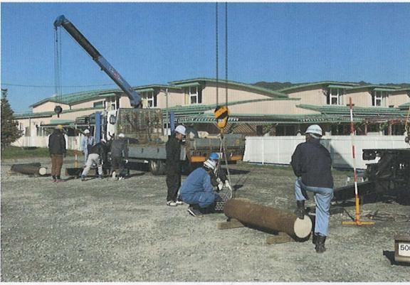
「玉掛け」とはクレーンなどに荷を吊らせる際、ワイヤーやロープなどを荷に掛け、運搬の合図を行う作業です。
